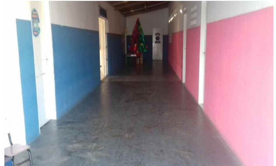
Figura 2: Corredor lado esquerdo da entrada principal da Creche
